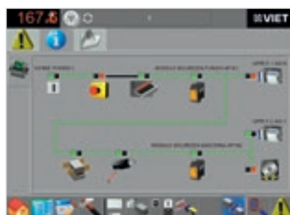
Comprobación de alarmas.
